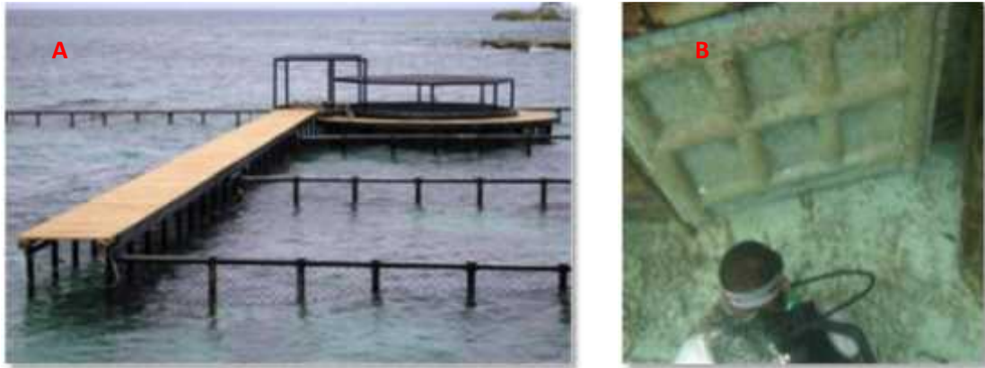
Figura 8. A. Encierros y corredor que conduce al tanque de reproductores; B. Compuerta de ingreso (Fuente CEINER)
